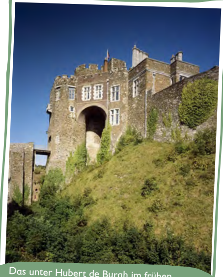
Das unter Hubert de Burgh im frühen 13. Jahrhundert erbaute Constable's Gate erhebt sich von einem riesigen und mit einer Böschung versehenen Fundament aus dem Burggraben.
