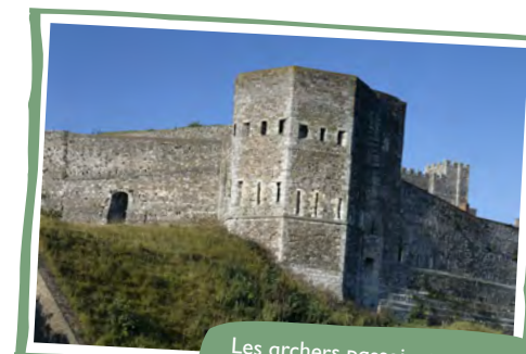
Les archers passaient leurs flèches dans les fines meurtrières pour viser les ennemis.
